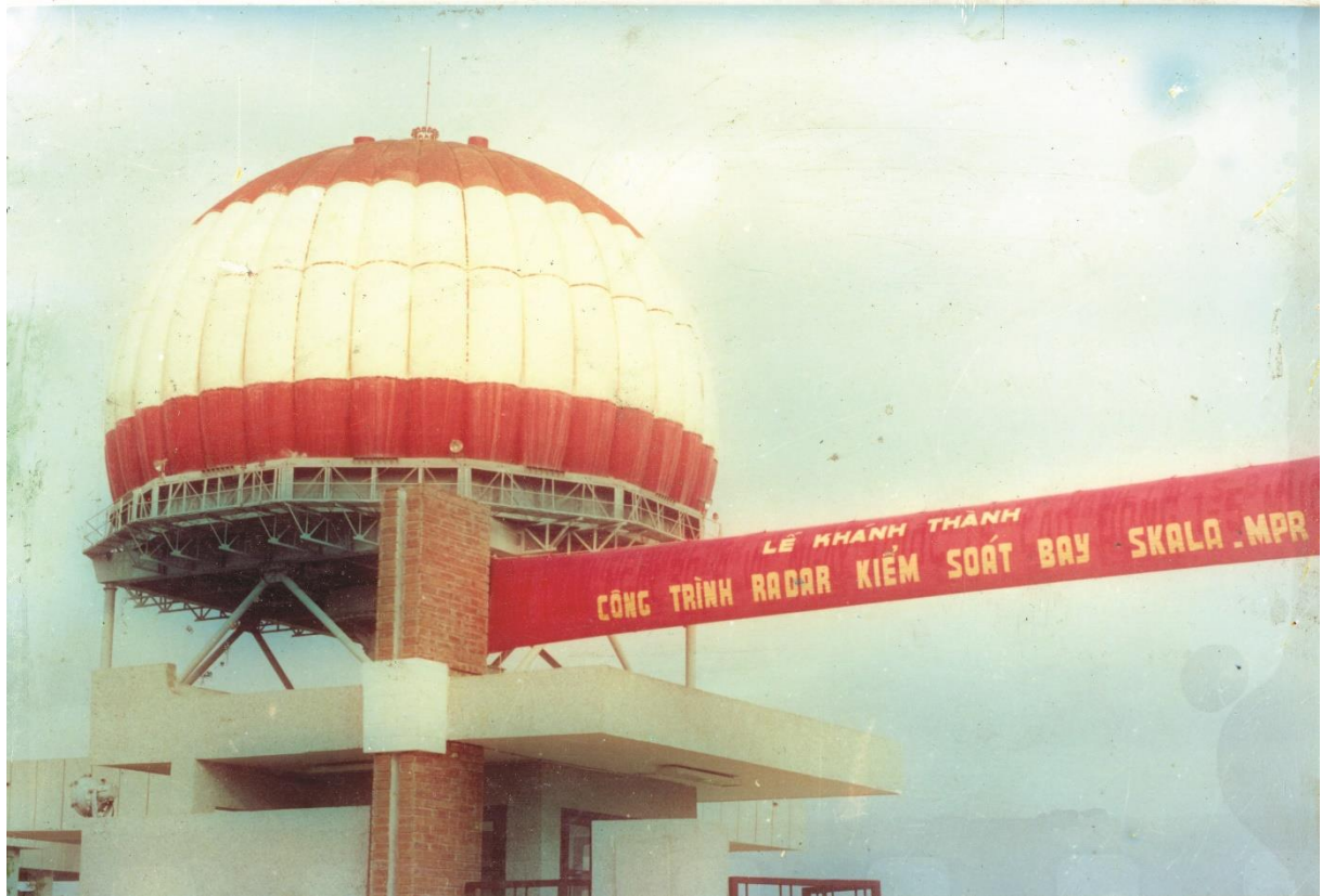
Trạm Radar SKALA-MPR Nội Bài.
